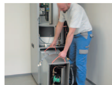
Nasunutí chladicího boxu do tepelného čerpadla.
